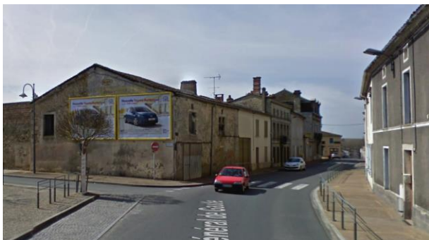
Bâtiment préexistant démolit
