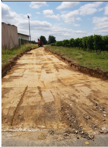
Accès chantier et futur accès pompier
